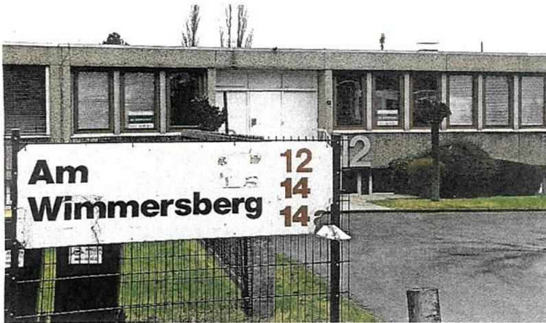
In Alt-Erkath könnten nicht oder teilweise genutzte Gewerbeimmobilien einem neuen Wohngebiet weichen.
